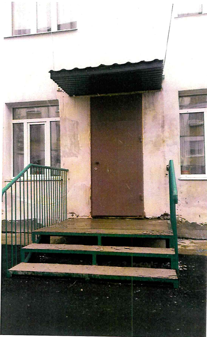
фото 2/1 (лестница и входная площадка перед дверью, входная дверь)
